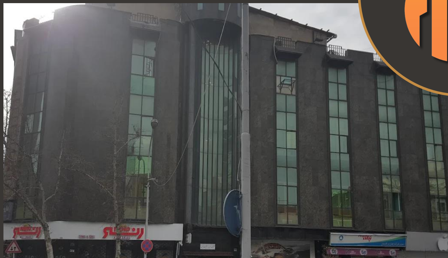
مرکز جراحی محدود مبین پاسداران طراحی و اجرای سامانه‌های اعلام و اطفاء حریق
