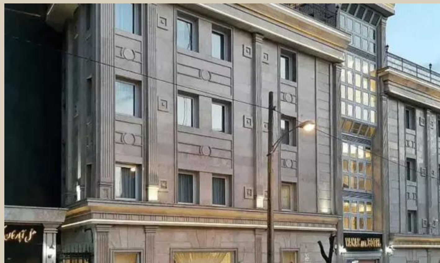
هتل آپارتمان ونک طراحی و اجرای سامانه‌های اعلام و اطفاء حریق
