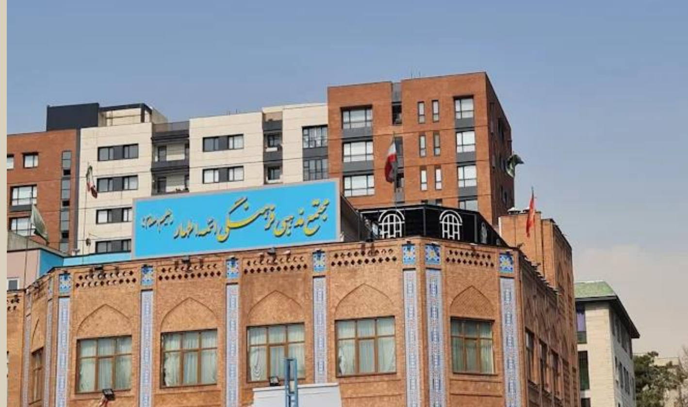
مجمع مذهبی فرهنگی ائمه اطهار طراحی و اجرای سامانه‌های اعلام و اطفاء حریق
