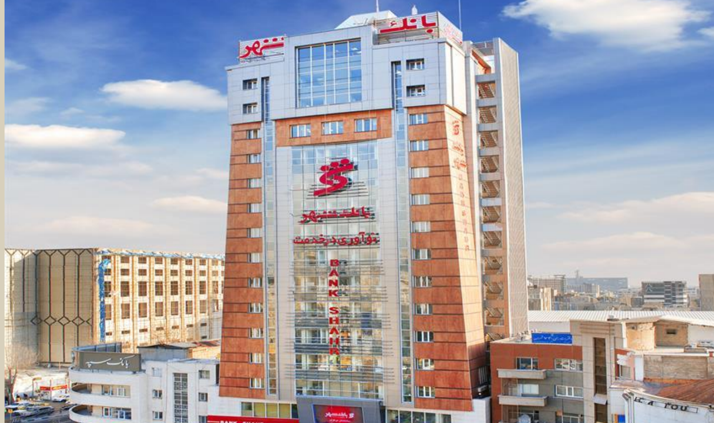
بانک شهر طراحی و ساخت بوسترپمپ آتش‌نشانی
